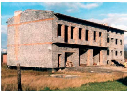
Remiza OSP Ornontowice w stanie surowym – 1994 r.
