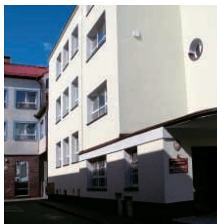
Termomodernizacja Zespołu Szkolno-Przedszkolnego
