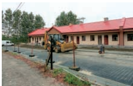
Budowa mieszkań socjalnych przy ul. Żabik
