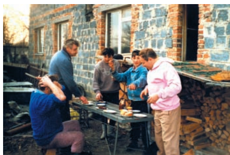
W trakcie budowy zakładu
