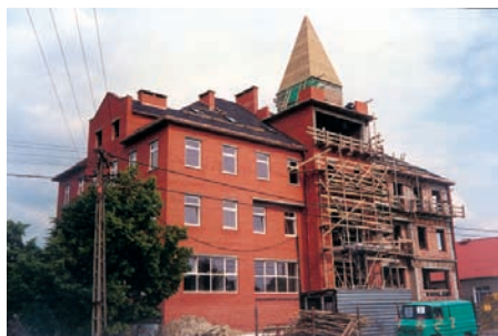
Budowa budynku Urzędu Gminy wraz z Bankiem – 1996 r.
