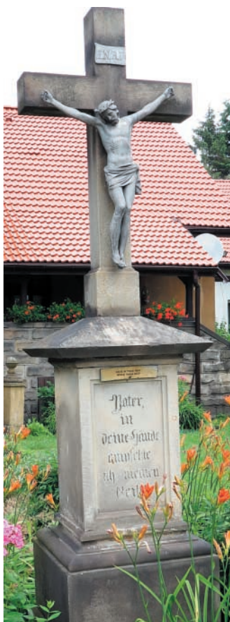
Krzyż przed wykonaniem prac...
