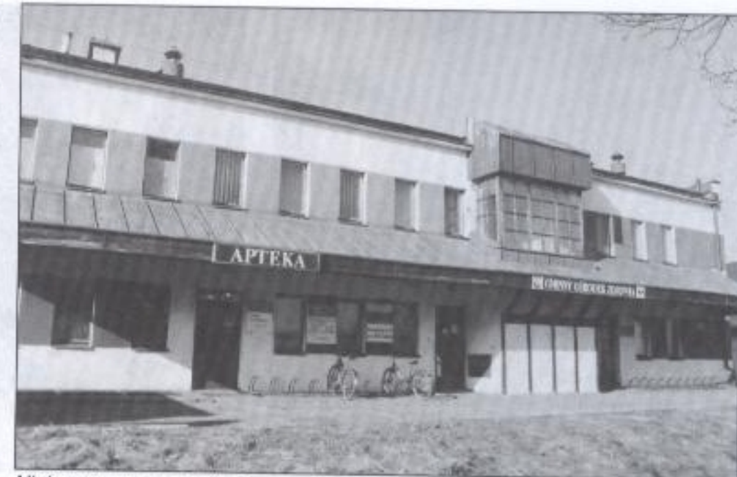
Niebawem rozpocznie się gruntowny remont miejscowego ośrodka zdrowia
