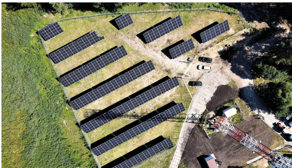
Instalacja fotowoltaiczna dla potrzeb Miejskiej Oczyszczalni Ścieków i placówek oświatowych, źródło: Miasto Kalety
