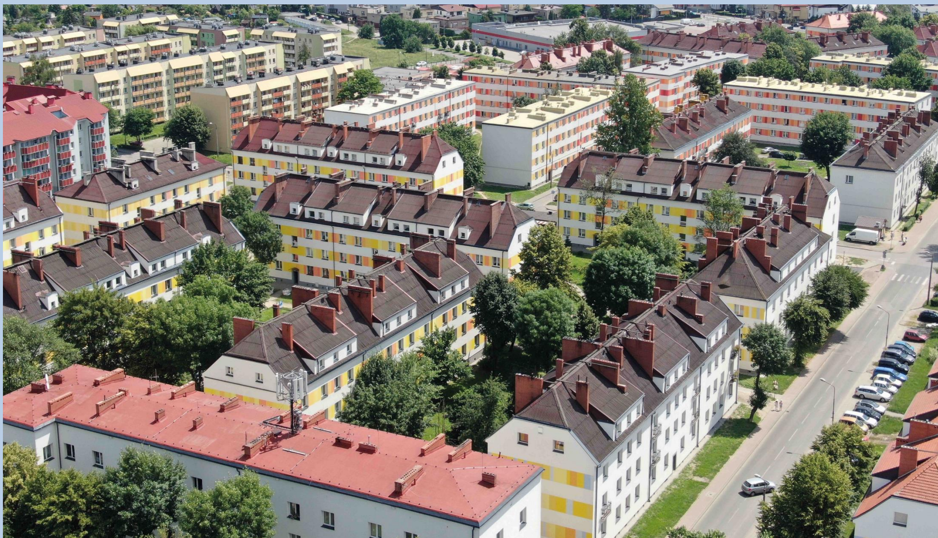
Podłączenie budynków do sieciowych źródeł ciepła oraz termomodernizacja w Piekarach Śląskich, źródło: Urząd Miasta w Piekarach Śląskich
