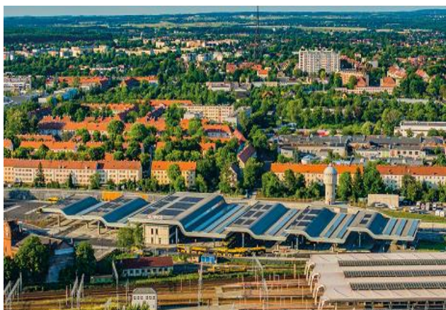
Centrum Przesiadkowe w Gliwicach, źródło: Urząd Miejski w Gliwicach
